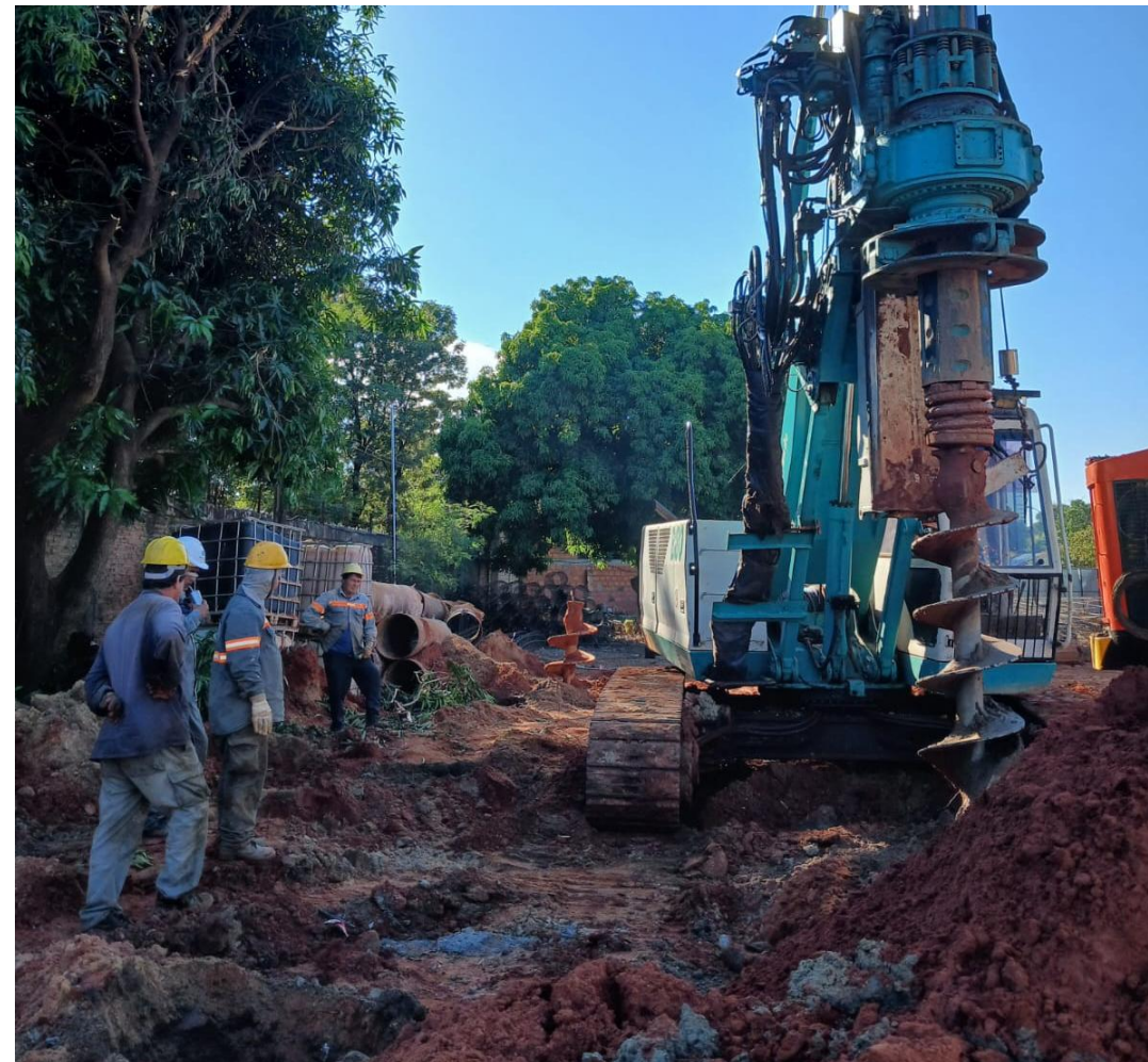
Trabajos de perforación de pilotes
