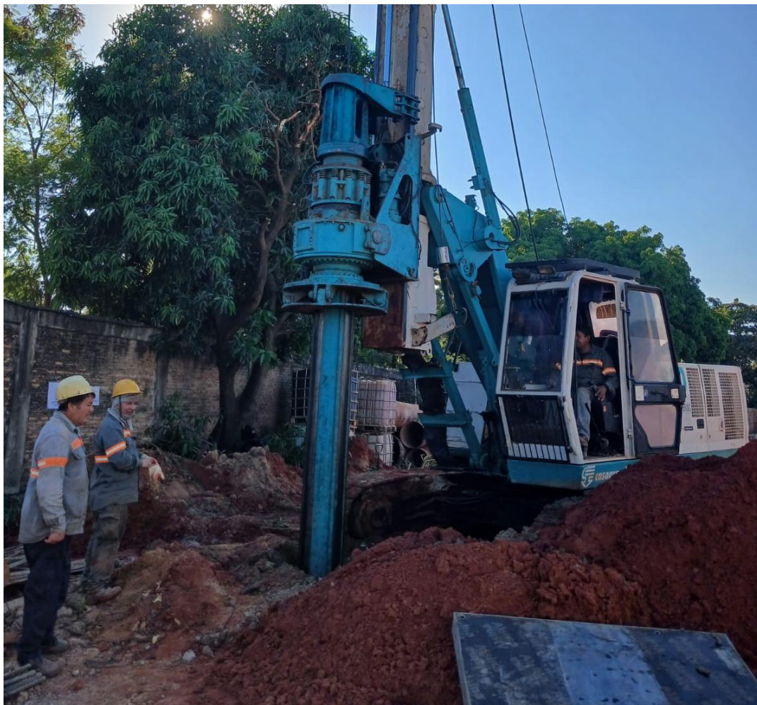
Trabajos de perforación de pilotes
